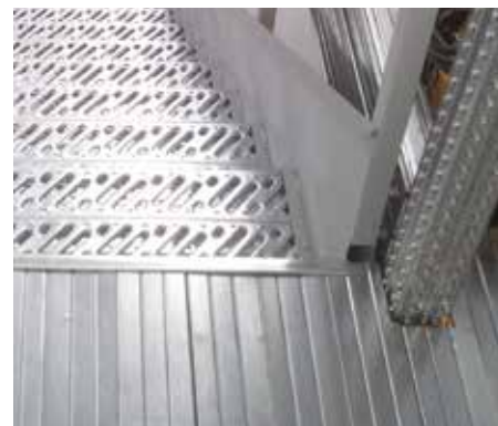
Suelo en acero galvanizado liso, peldaños en acero galvanizado perforado.
