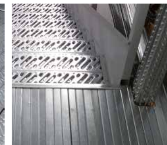
Suelo en acero pregalvanizado liso, peldaños en acero pregalvanizado perforado.
