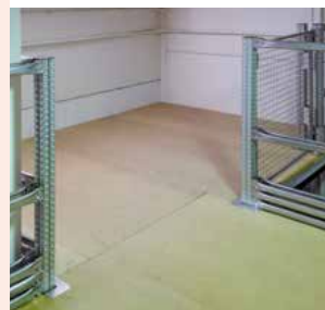
Suelo de tableros DM machiembrados.
