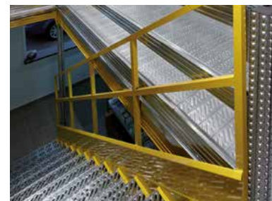
Suelo en acero pregalvanizado embutido, peldaños en acero pregalvanizado perforado.
