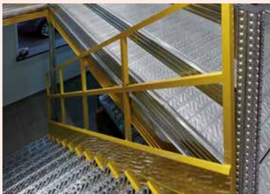
Suelo en acero pregalvanizado embutido, peldaños en acero pregalvanizado perforado.
