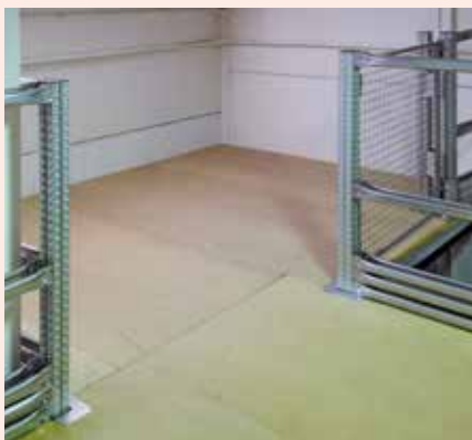
Suelo de tableros DM machiembrados.
