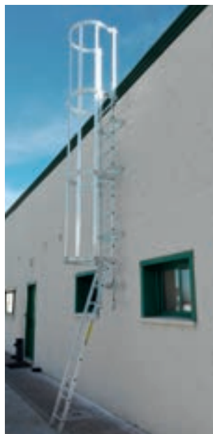
Tramo inferior móvil con trampilla anti-acceso
