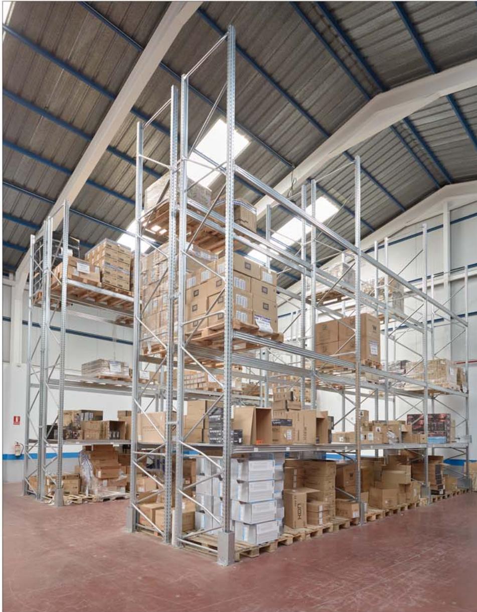
Instalación de Estanterías de paletización suelo + 3 niveles
