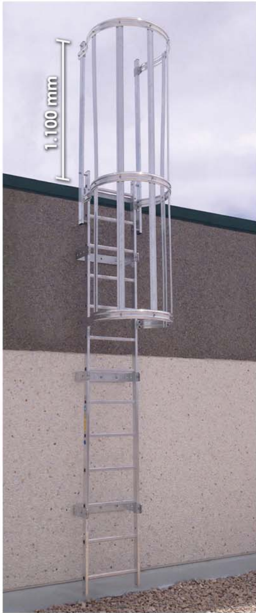
Altura mínima del aro superior de protección de espalda sobre la altura de desembarco: 1.100 mm
